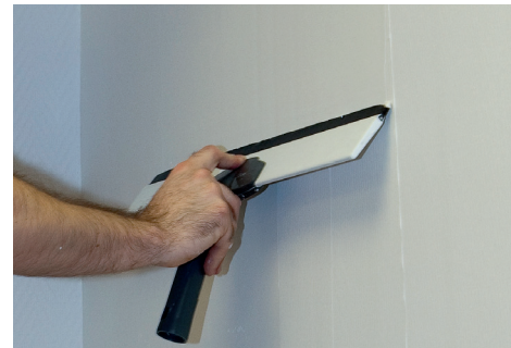
Surfacer L'enduit avec le lisseur à lame lisse souple
