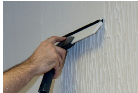
Égaliser L'enduit avec le lisseur à lame crantée
